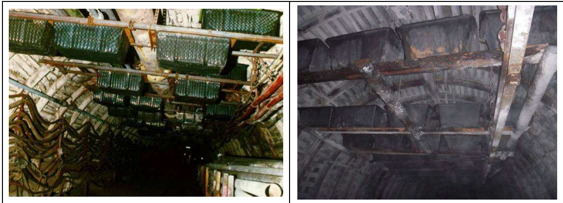
Fotografía C.1. Barreras de cubas de agua dispuestas en el techo de las galerías
